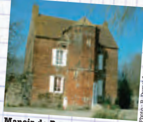
Manoir de Pernes-lès-Boulogne en briques.
