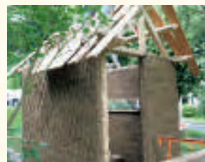
L'observatoire prêt pour la pose de l'enduit, dont le torchis est quadrillé.
