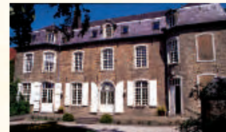
De la pierre pour les bâtiments « nobles » : le manoir du Huisbois à Le Wast.
