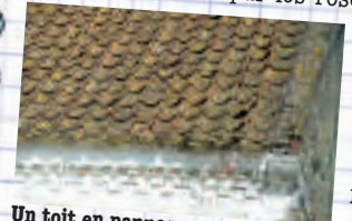
Un toit en pannes.
