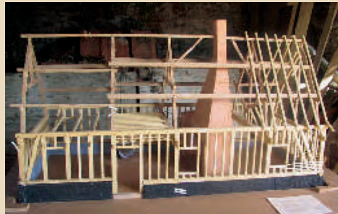
Cette maquette montre l'importance accordée à la cheminée dans le bâti traditionnel.
