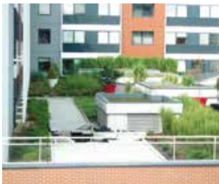
Toiture intensive Immeuble à Rive étoile - Strasbourg © SB - Eurométropole de Strasbourg
