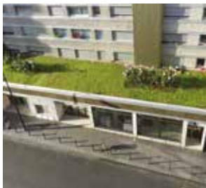
Toiture semi-intensive Hôtel parisien © RG - Eurométropole de Strasbourg
