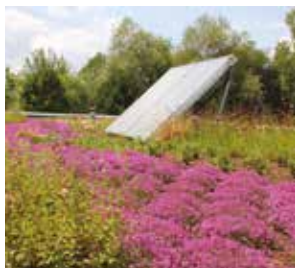
Toiture expérimentale Locaux de la SAS Thierry Muler © TM - SAS
