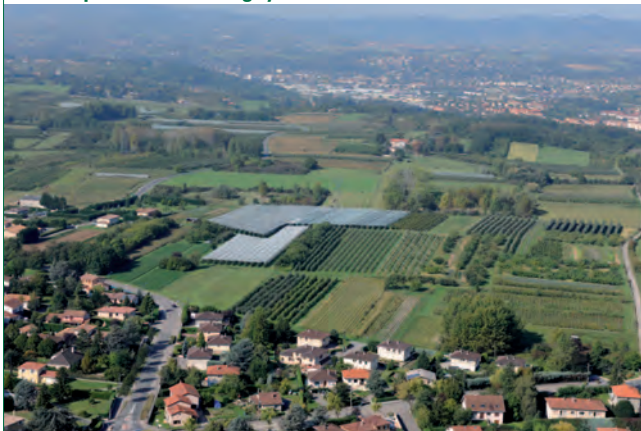
Habitat pavillonnaire à Irigny
